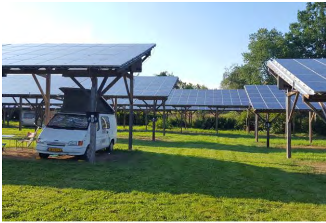
Camper plaatsen onder de panelen
