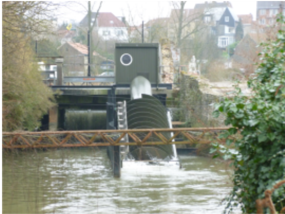
Figuur 1 Waterkrachtcentrale met vijzel.
