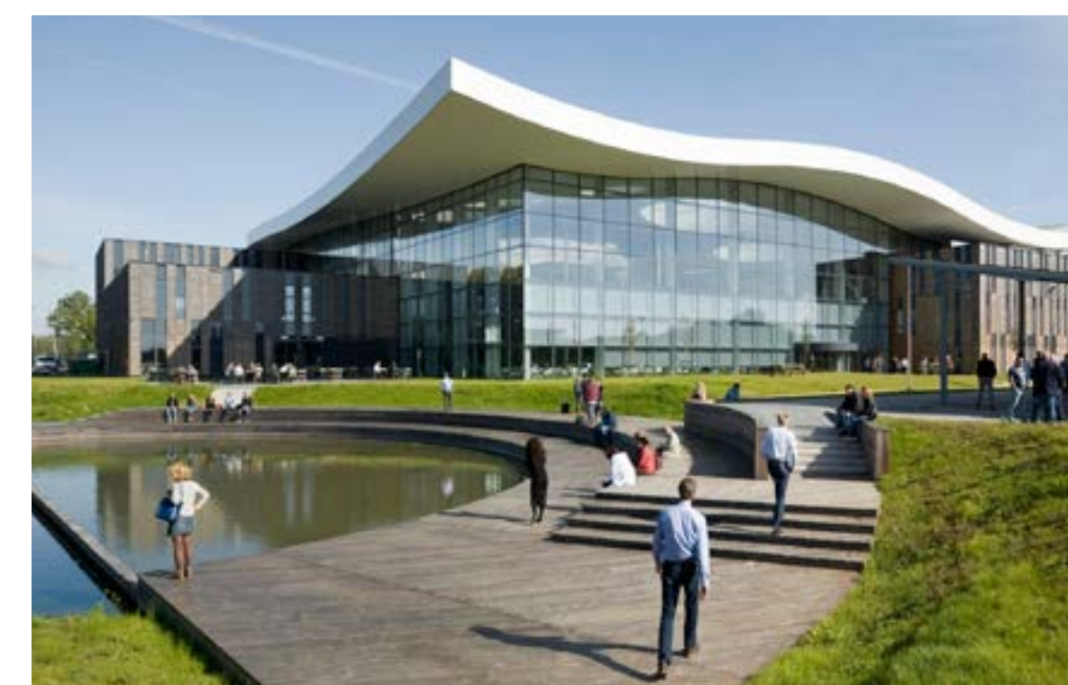
Nieuwe hoofdkantoor van Alliander in Duiven
