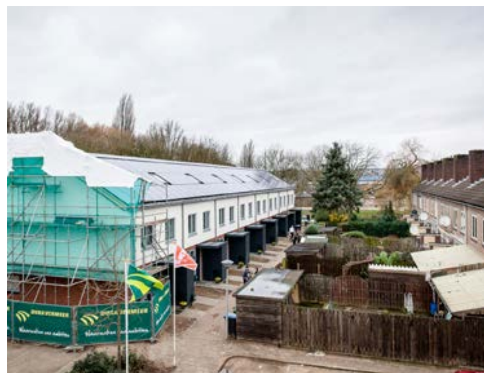
Renovatieproject van Portaal in Arnhemse wijk Presikhaaf (foto: Dory Aling)
